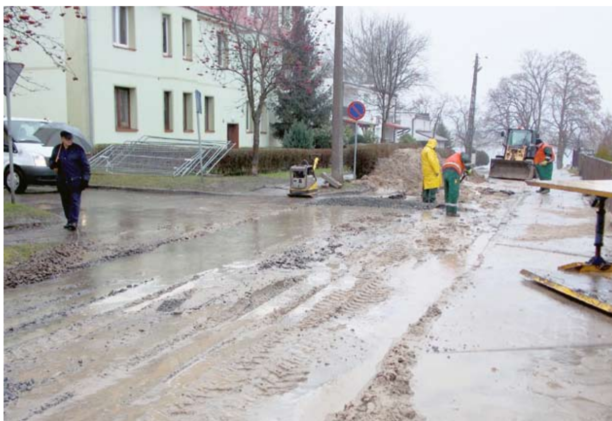
Investycja dofinansowana w konkursie na działanie 3.3. Nowogard, ul. Waryńskiego rozdzielanie kanalizacji sanitarnej od ogólnospławnej
